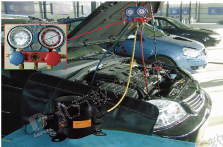
图 3 打压实验（表组及打压泵空调系统连接图）
