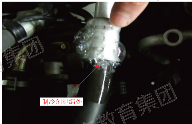
图 2 制冷剂泄漏处
