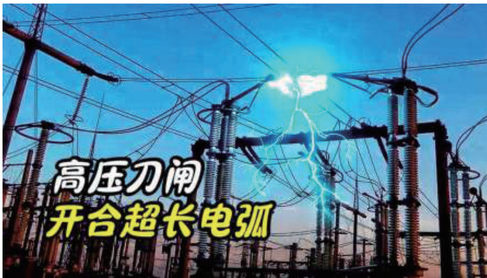
图 5-1-3 开断电路时产生的电弧
