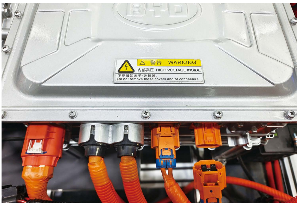
图 1-3-29 拔下高压分配器上的 PTC 的高压插头
