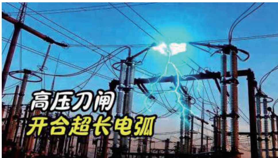
图 5-1-3 开断电路时产生的电弧
