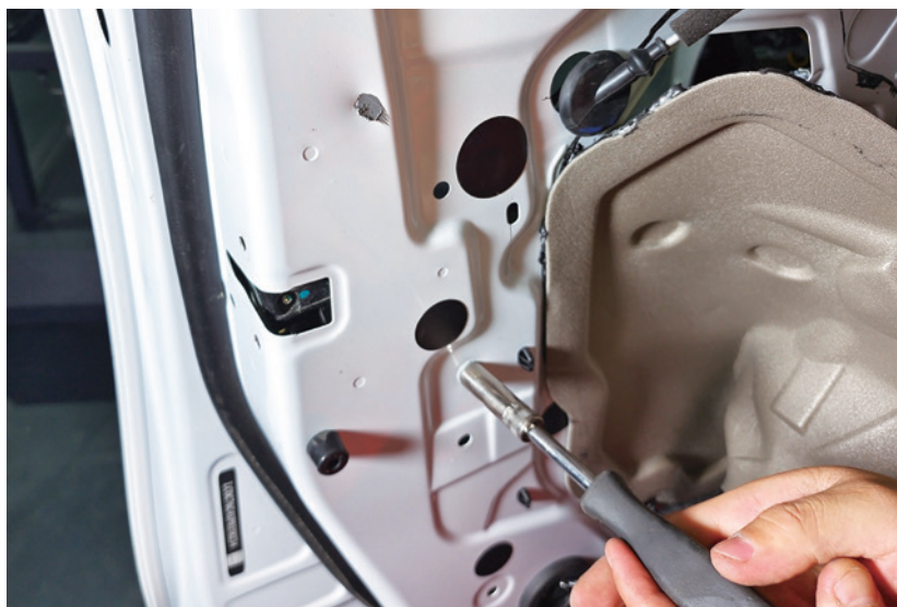
图 4-1-25 拆下车窗玻璃后侧导轨螺丝
