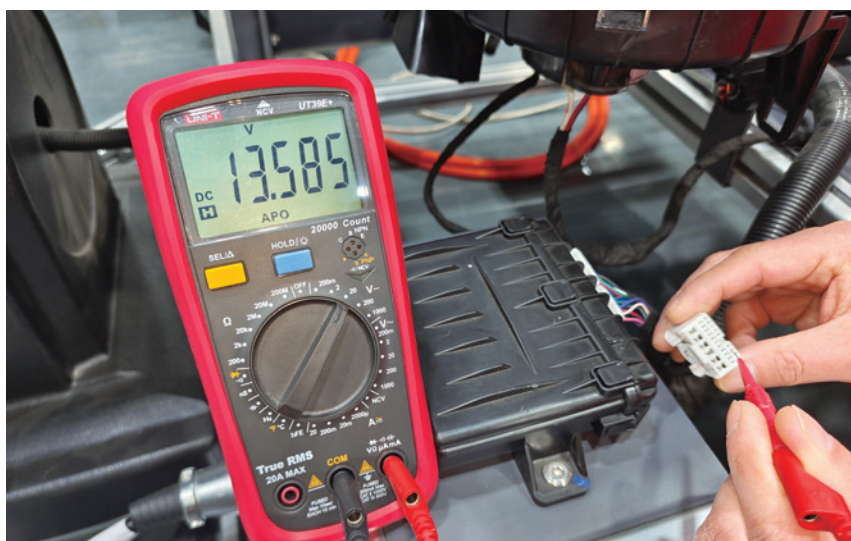
图 6-3-11 空调控制器 G21 (A) 插头的 20 号端子电压测量
