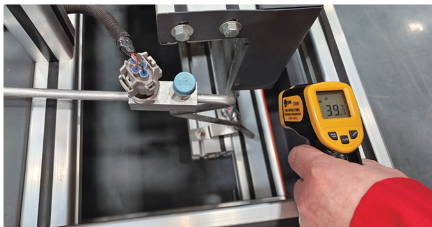
图 2-1-20 冷凝器出口温度
