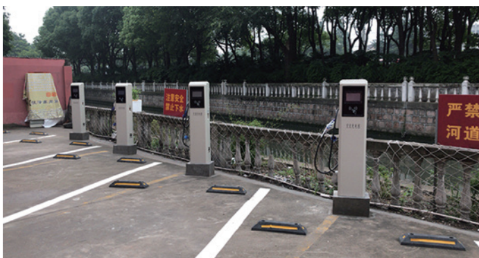
图 6-1-3 电动汽车交流充电桩
