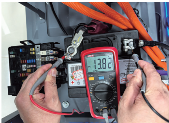
图 5-3-10 测量蓄电池电压
