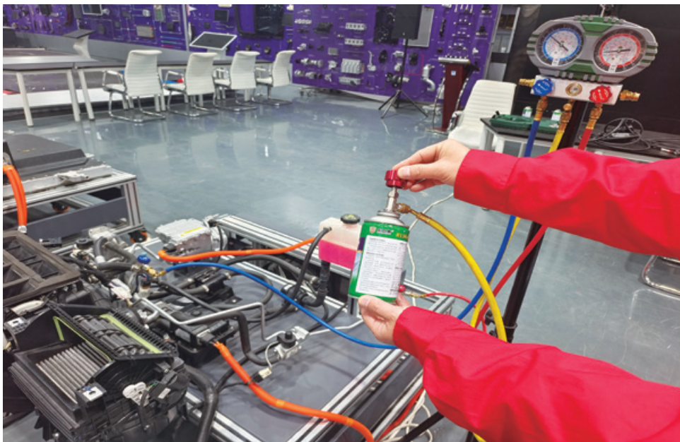
图 2-6-13 低压侧充入液态制冷剂（制冷剂罐正立）
