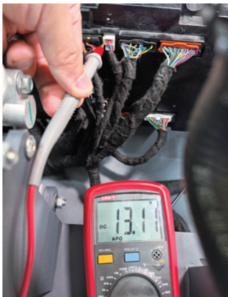
图 5-1-11 测量集成控制器（空调）电源
