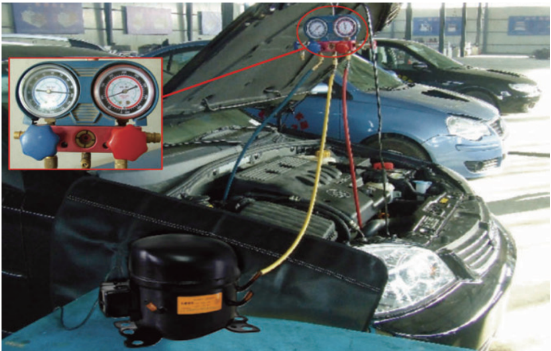
图 2-6-11 打压实验（表组及打压泵空调系统连接图）
