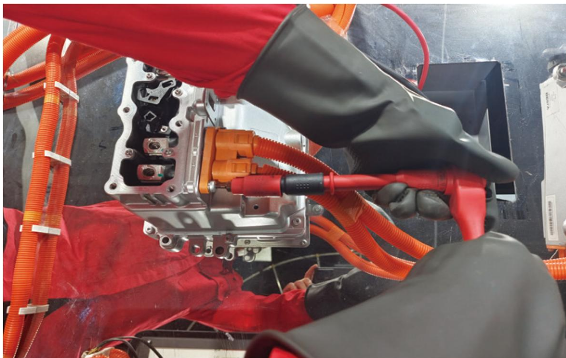
图2-20 拆下高压电缆固定螺栓
